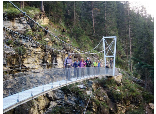
Hängebrücke im Val Sinestra
