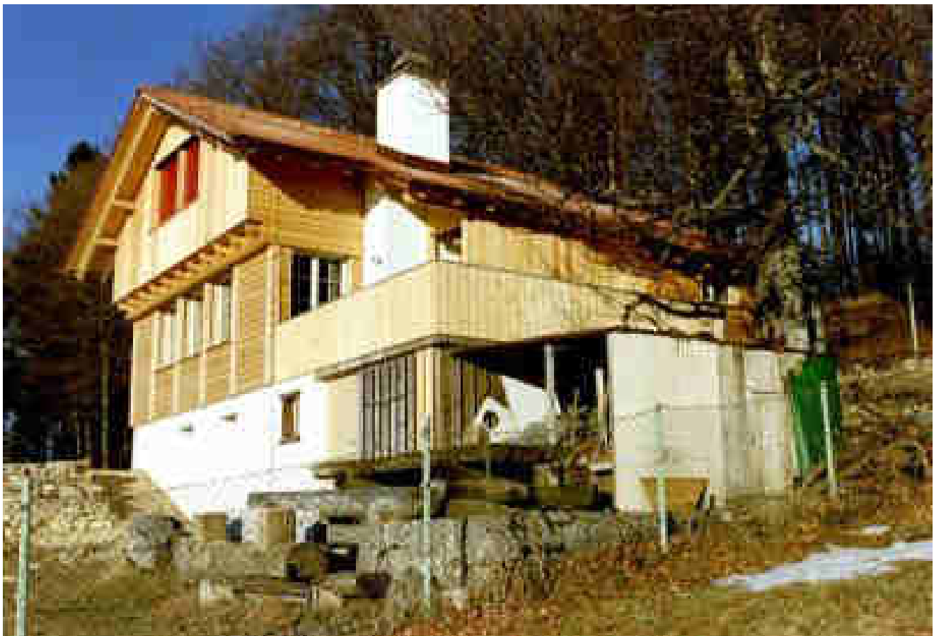
Unser Chalet im Jahr 2000, kurz nach dem Umbau
